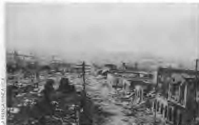
ESTRAGOS DEL TERREMOTO DE MANAGUA, 1931.
